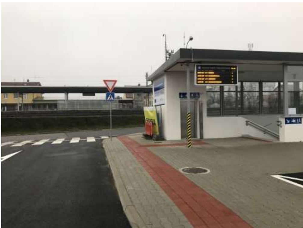
Schodisko do podchodu nemá žliabky pre bicykle.
