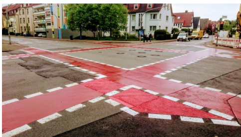
Osnabrück a cykloinfraštruktúra, str.8
